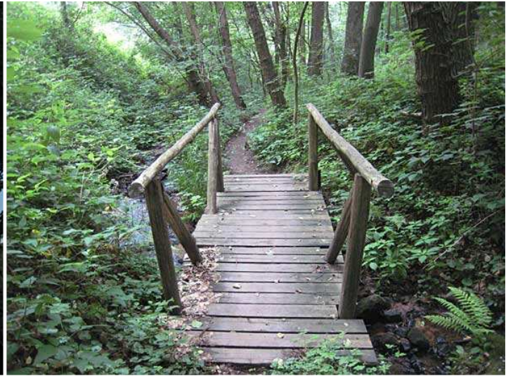
Brücke über den Kropsbach (vor St. Martin)
